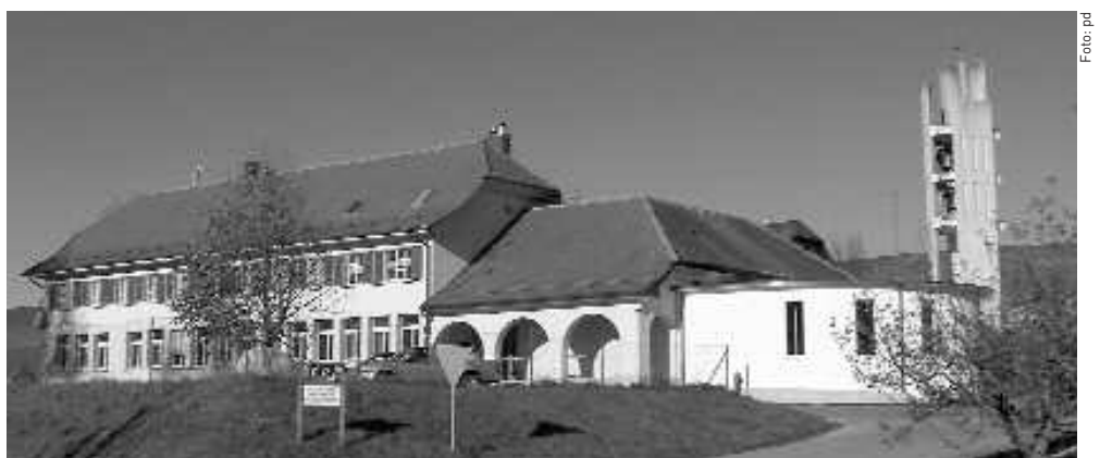
Das reformierte Zentrum Weissenstein/Rechthalten nach dem umfassenden Umbau
