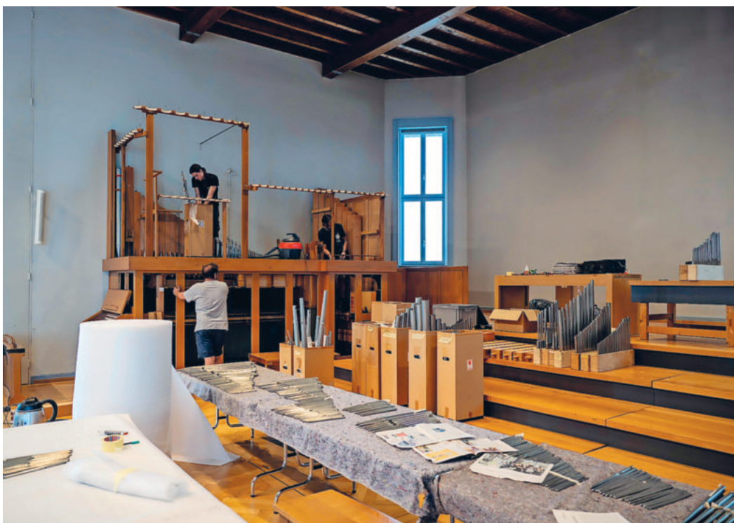
Abbau der Orgel durch die Firma Orgelbau Kuhn AG, Männedorf.
